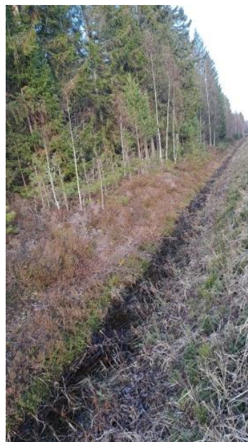
Z8-3. attēls. Esošā grants ceļa sāngrāvis
