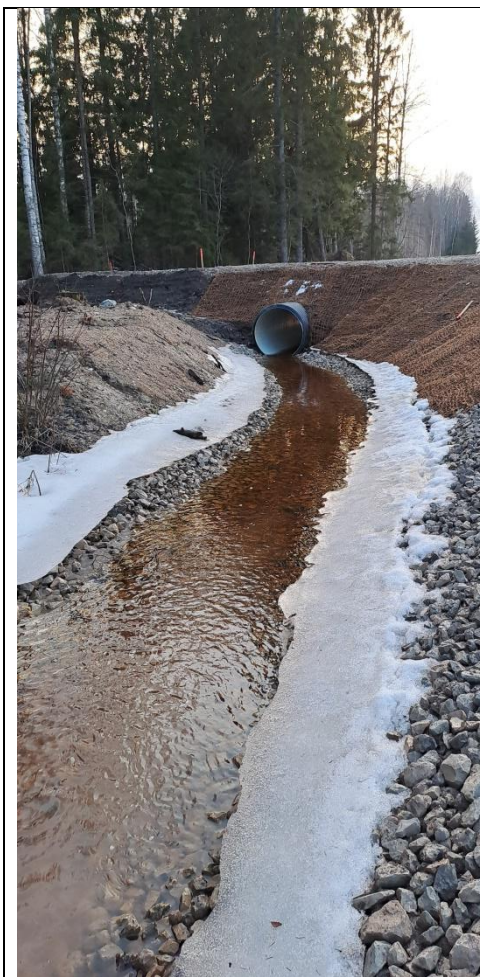
Z13-3 attēls. Skats uz susinātājgrāvja MK 54113:26 caurteku
