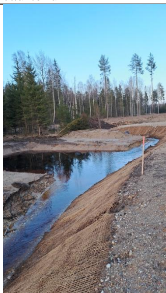
Z13-5 attēls. Skats uz ūdensnotekas MK 54113:VI:15 sedimentācijas baseinu
