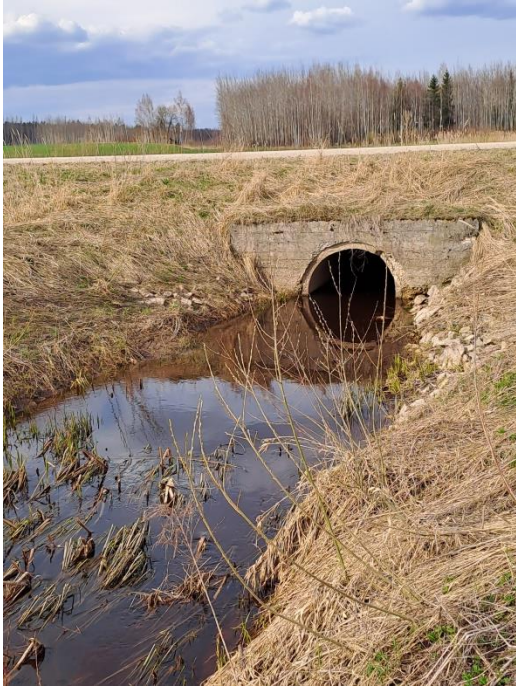
7.attēls Bormaņu grāvja caurteka zem piebraucamā ceļa (skats uz izplūdi, punkts 1)
