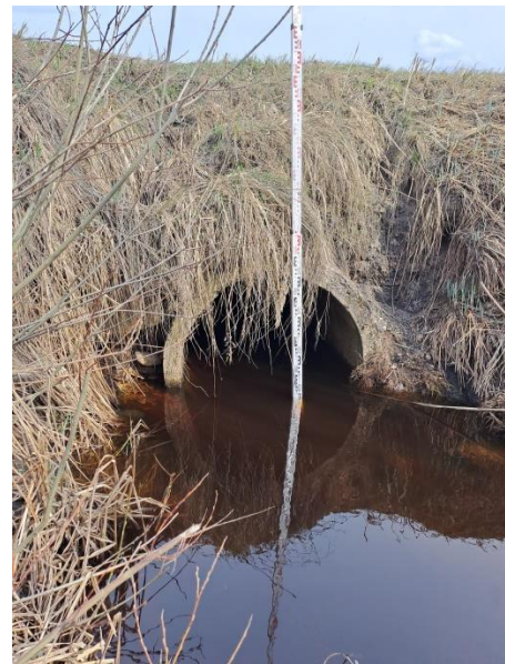
10.attēls Novadgrāvja ŪSIK kods 41614:K:3 caurteka zem P79 Vecbebri-Koknese (skats uz ieplūdi, punkts 4)
