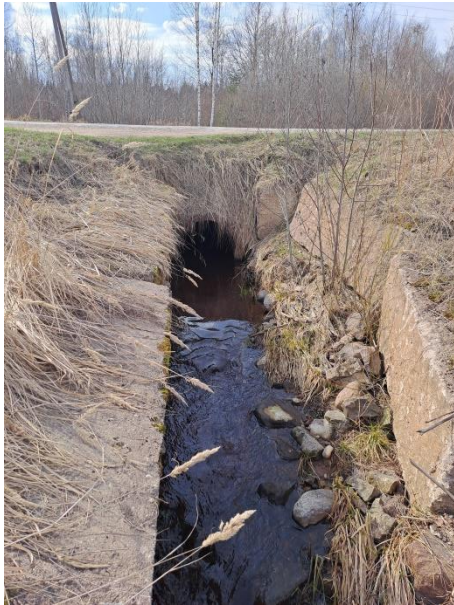
13.attēls. Novadgrāvja ŪSIK kods 41614:K:3 caurteka zem P79 Vecbebri-Koknese (skats uz izplūdi, punkts 3)
