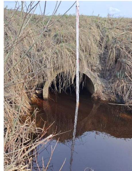
14.attēls. Novadgrāvja ŪSIK kods 41614:K:3 caurteka zem P79 Vecbebri-Koknese (skats uz ieplūdi, punkts 4)
