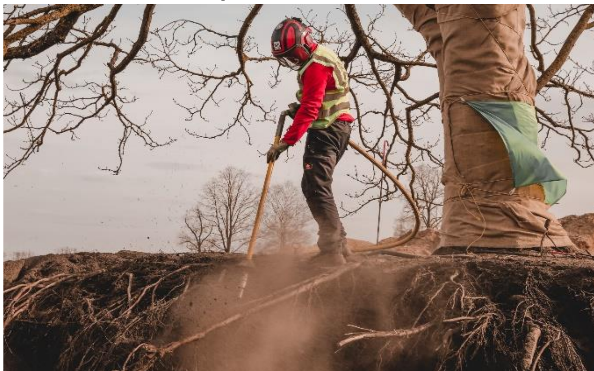
7.att. Sakņu kamola sagatavošanas darbi ar pneimatisko (gaisa) lāpstu
