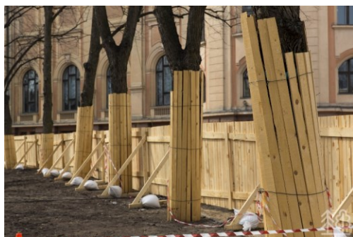
1. attēls "Individuālā koku stumbru aizsardzība"; 2. attēls "Pagaidu žoga piemēri"
