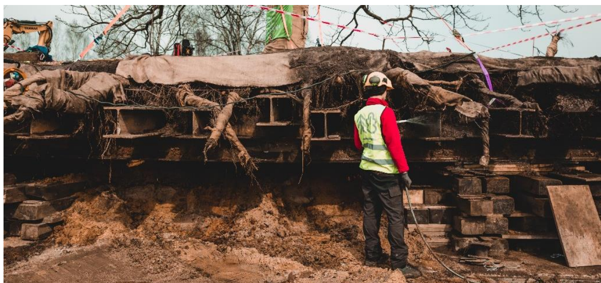
5.att. Sakņu kamola sagatavošanas darbi
