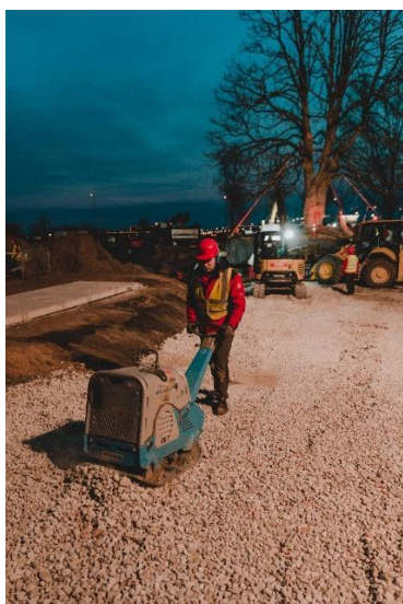
6., 7.att. Piebraukšanas un pārvešanas ceļa sagatavošana tehniskajam transportam
